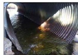
Vue intérieure d'un ponceau source : Pierre-Marc Constantin
