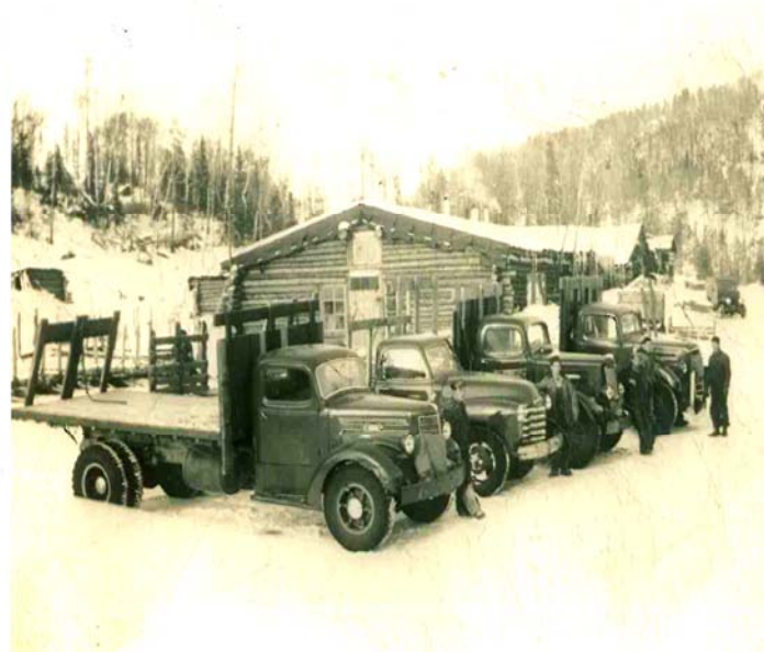
Camions de M. Émilien St-Onge à Caissy Chantier de M. Maurice Edmond Mc Murray
